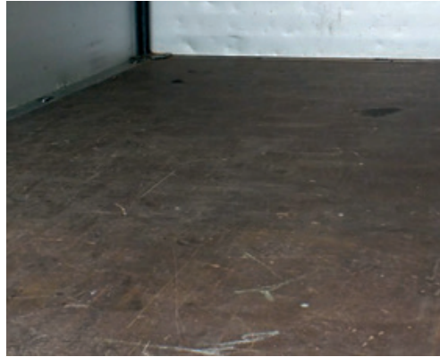
Nutzungsbedingte Kratzer Laderaumboden
